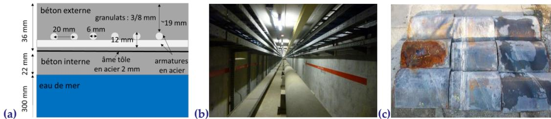
**FIGURE 1.** (a) Schéma d'une coupe de CBAT, photos (b) d'une CBAT en galerie et (c) de morceaux de l'âme tôle corrodée après découpage du tronçon et piquage du béton.
