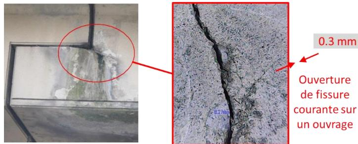
**FIGURE 2. Fissures au coin des consoles cantilever**
